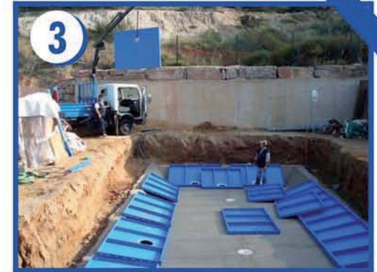
Colocación de paneles
