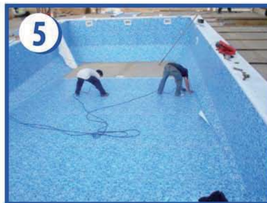
Colocación lámina armada
